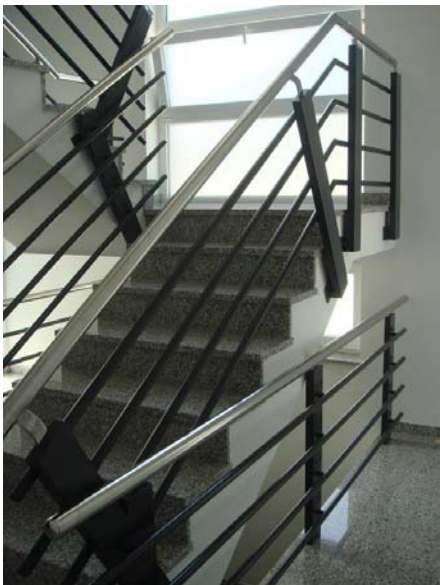
Pogled na stubište
